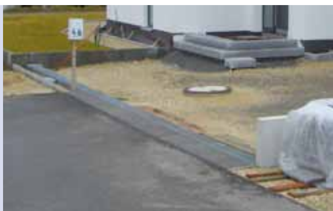
Verstopfte Ablaufrinnen (li.) verhindern die Entwässerung auf dem hauseigenen Gelände und überlasten die öffentlichen Gullis. Private Hofflächen dürfen deshalb nicht auf die Straße entwässert werden. Hausbesitzer sind verpflichtet, das Wasser über eine funktionstüchtige Rinne (re.) aufzufangen.
