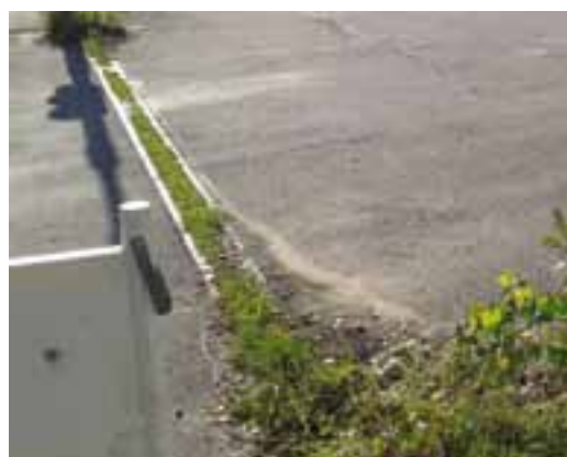
Verstopfte Ablaufrinnen (li.) verhindern die Entwässerung auf dem hauseigenen Gelände und überlasten die öffentlichen Gullis. Private Hofflächen dürfen deshalb nicht auf die Straße entwässert werden. Hausbesitzer sind verpflichtet, das Wasser über eine funktionstüchtige Rinne (re.) aufzufangen.
